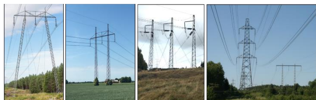
Figur 3. Stagad portalstolpe, Ostagad portalstolpe, vinkelstolpe respektive julgransstolpe.
