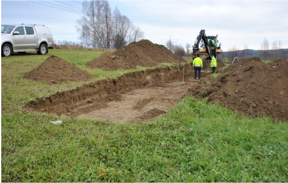
Fig. 28. Schakt 41 vid Raä 100 och ett drygt 1 meter djupt matjordslager, i botten fanns fynd av små obestämbara järnfragment men även små tegelbitar. Foto mot öster.
